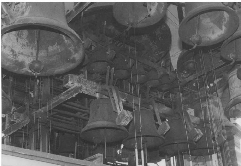
Cloches de carillon avec marteaux (situés à l'extérieur) pour le jeu automatique et battants (situés à l'intérieur) pour le jeu manuel.
