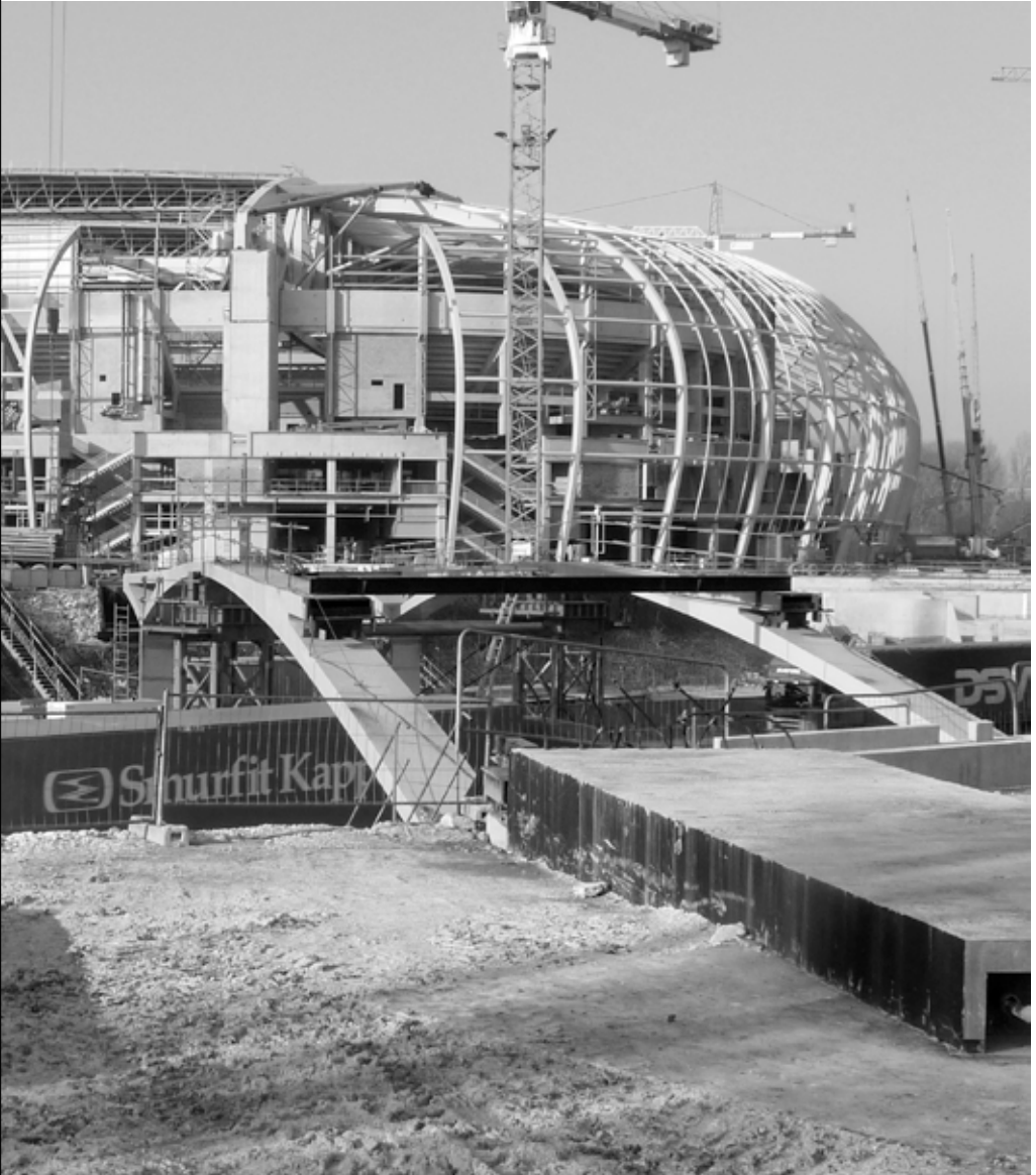
Grand Stade et future passerelle d'accès piétons
