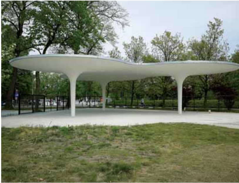
John Körmeling, pavillon en construction à l'entrée du musée Middelheim , acier, gunité, 2008-2009, parc de Middelheim (Anvers).
