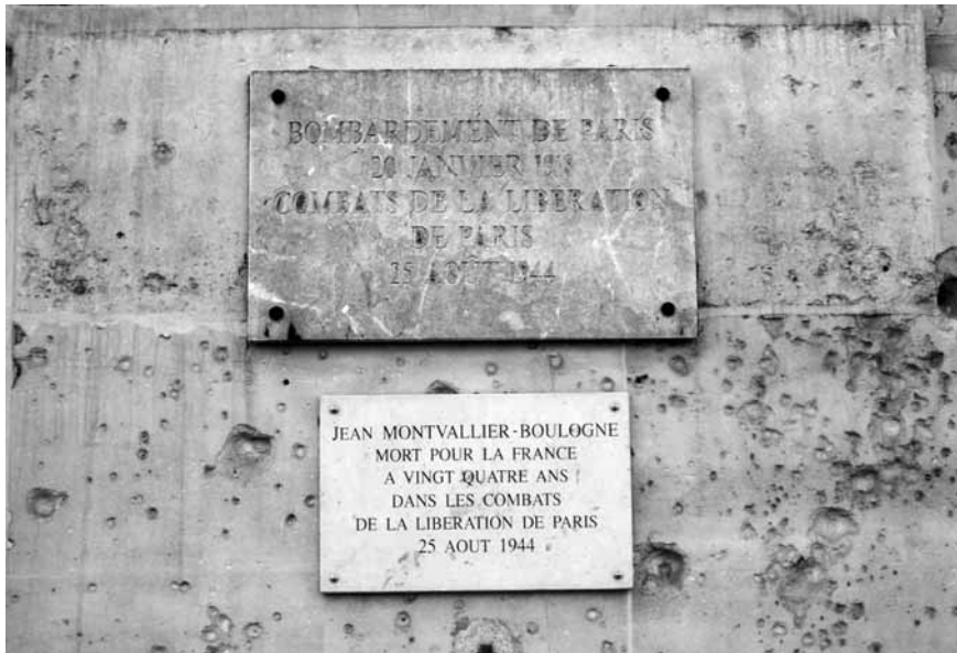
Le mur de l'École des Mines, photo M. Koffeman.
