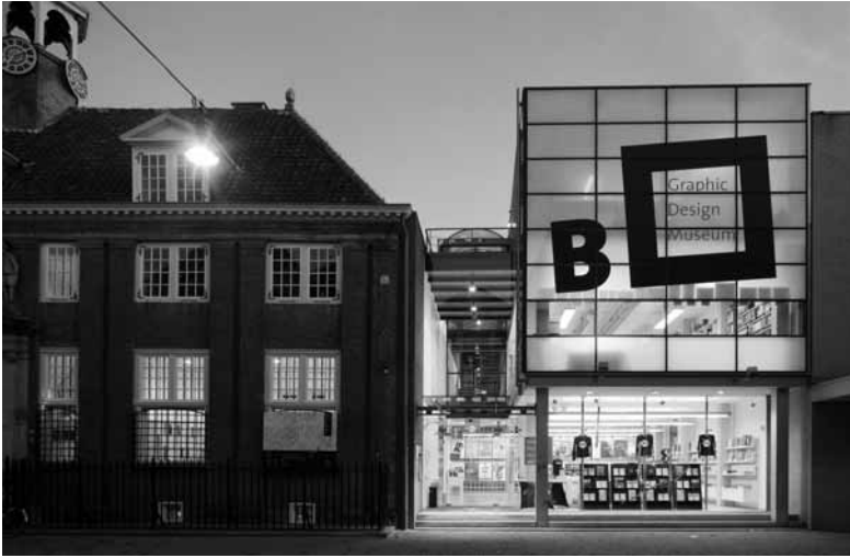
La façade du Graphic Design Museum , conçue par Hans van Heeswijk Architecten , photo L. Kramer.
