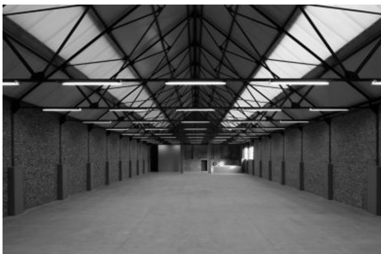
Nouvel espace d'exposition dans un entrepôt entièrement rénové, photo Ph. De Gobert © Herbert Foundation.
