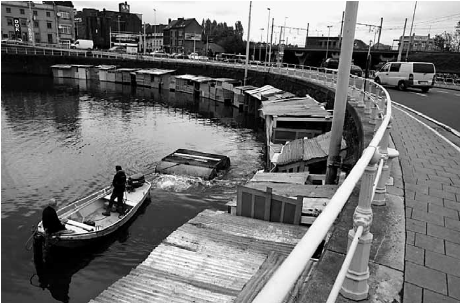
Track : un bidonville en construction près de la Dampoort à Gand. Projet de l'artiste japonais Tadashi Kawamata.
